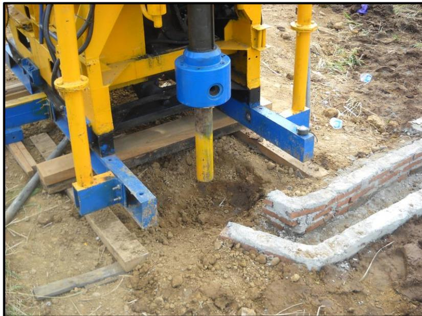
**Gambar 4.7. Peletakan alas penumpu dan kerangka dasar mesin bor.**
