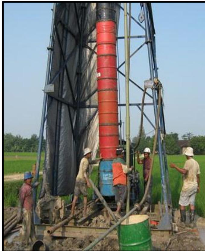
**Gambar 4.6. Drum casing sebagai casing sementara bagian atas lubang bor**
