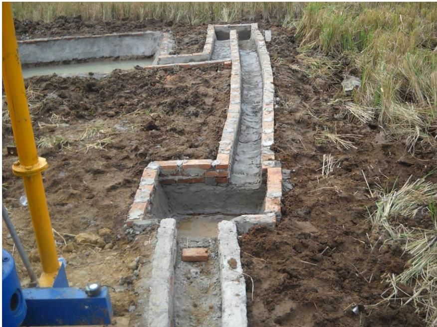
**Gambar 4.9. Parit saluran penghubung lubang bor ke bak sirkulasi fluida dan bak kontrol**
