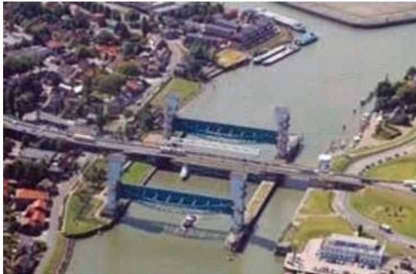
**Gambar 4.2. Pintu Gerak Air di Muara Sungai Rhine**
