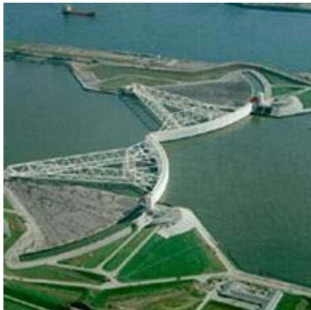
**Gambar 4.3. Pintu Gerak Air untuk Menahan Kenaikan Air Laut**
