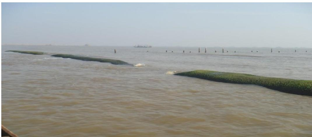
**Gambar 2.14. Pemecah PEGAR di Pasir Putih, Serang – Banten**
